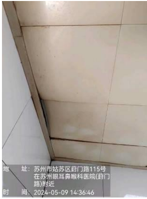
吊顶破损且陈旧 插板未按原样修复
